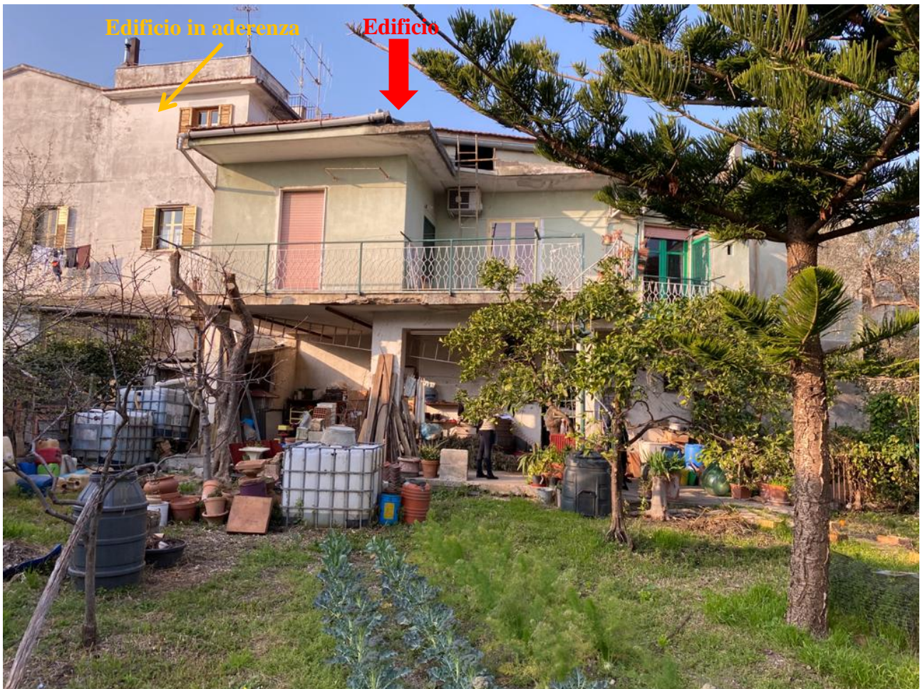
Vista da giardino interno di proprietà
